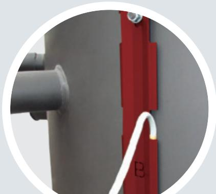
Ispravno postavljanje senzora na terminalnu traku, presudno je za optimalni rad kotla!
